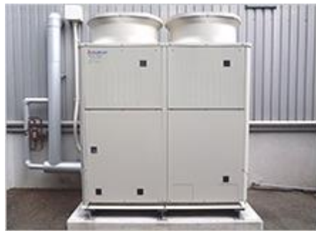
福岡工場 冷凍機設備更新 (省エネ)
