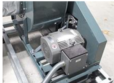
空調機吸排気ファン更新 (省エネ)
